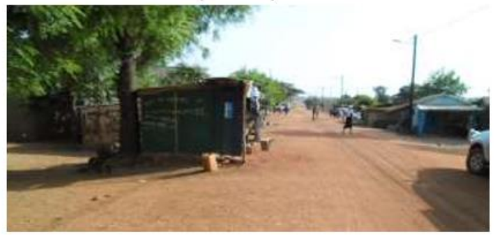
Baraque dans l'emprise de la chaussée à dégager
