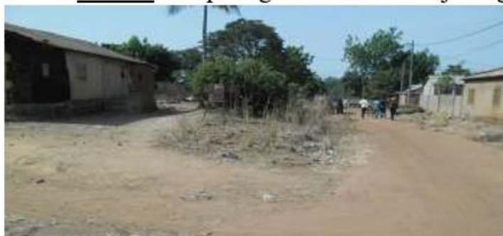
Dépotoir dans l'emprise de la chaussée à dégager
