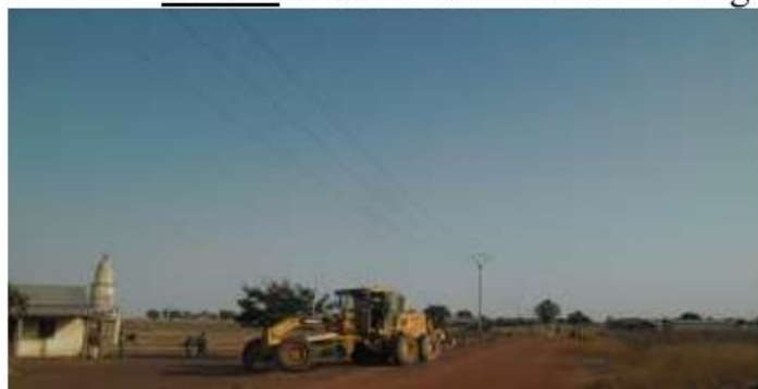
Vue du grader garer pour le redémarrage des travaux
