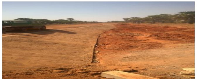
Protection du talus au PK 12+200
