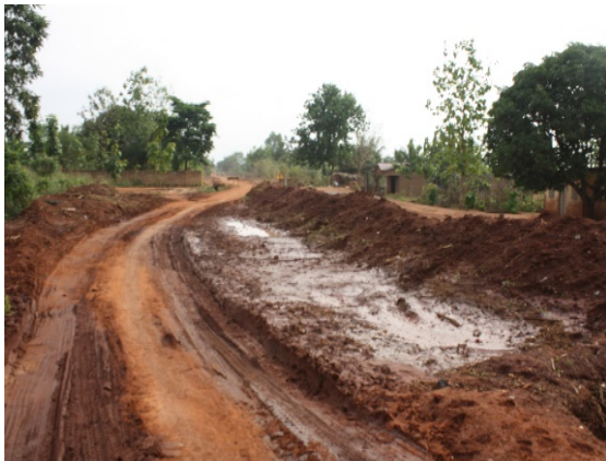
Photo 1 : Vue de la piste avant le démarrage des travaux
